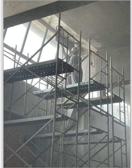
Raspagem e recuperação das armaduras e cobrimentos
