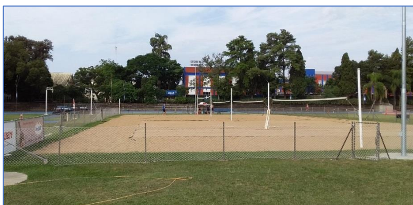
Substituição de postes e redes
