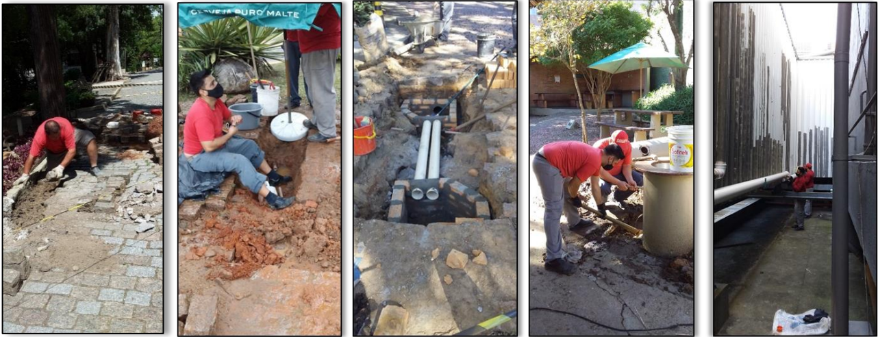
Substituição parcial da tubulação da rede de abastecimento de água quente da piscina térmica: antes e depois.
