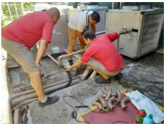
Instalação de bomba de calor para aquecimento da piscina infantil
