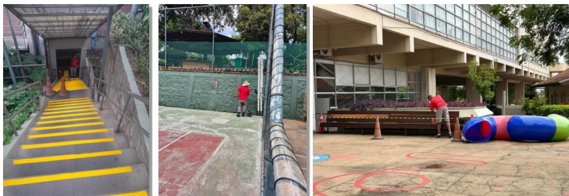
Pinturas diversas de ambientes internos, externos, sinalizações, mobiliários e esquadrias.
