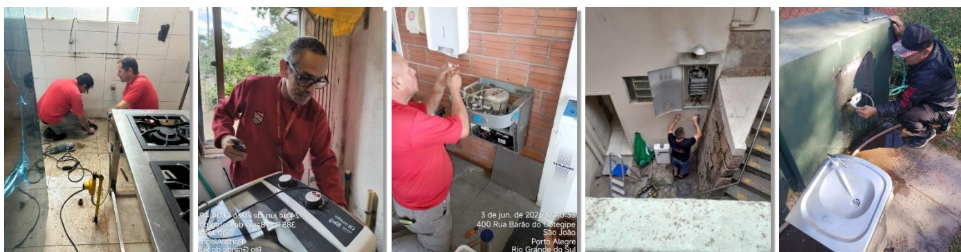
Limpeza e hidrojateamento das caixas de gordura e esgoto- Preventiva
